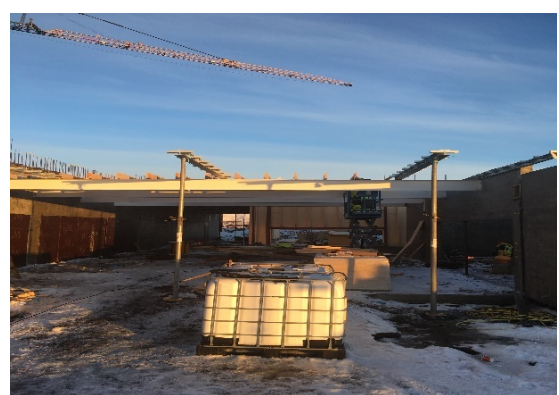
Unnið við þakvirki yfir móttökusalnum
