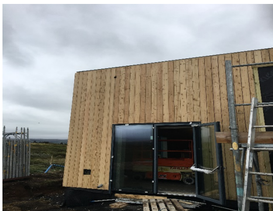
Unnið við klæðningar
